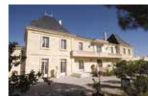
Château Arcins et Barreyres © Castel
